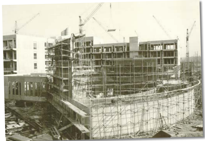
Baustelle des Hörsaals 3A
