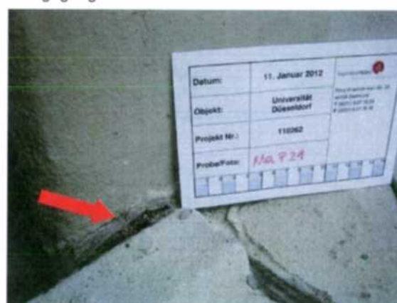
Foto 5.13: PCB-haltige Dichtmasse im Außenbereich zwischen Fassade und Balkonbeton- boden; hier Balkon vor Raum 23.02.02.25
