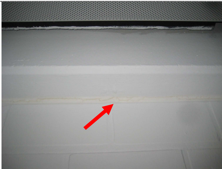
Material: Fugenanschluss Wand / Decke
