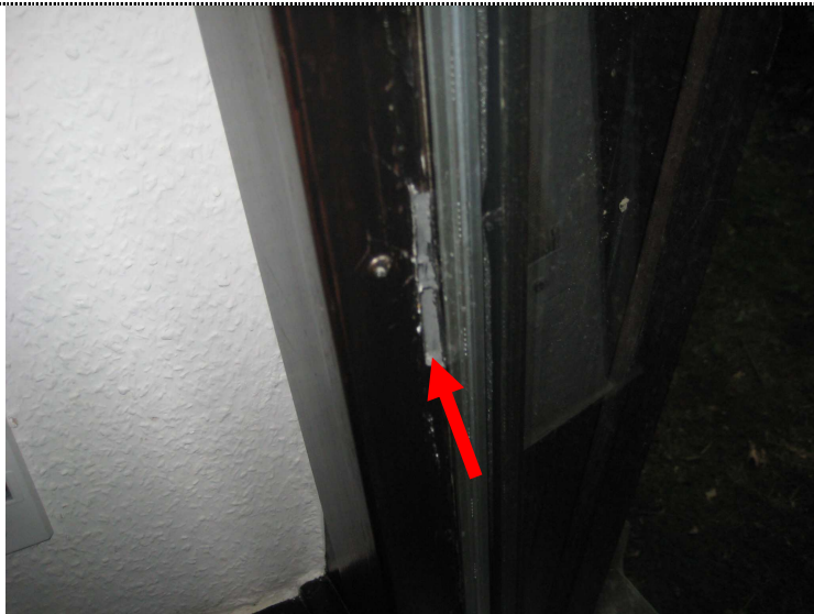
Negativfundstelle: Fugenmasse Fenster innen
